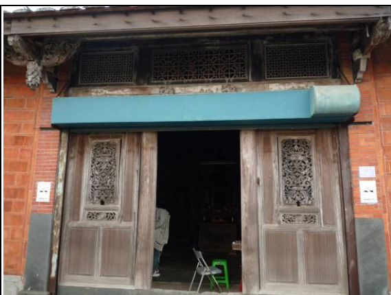
照片 2-8 電器設備定期檢測
