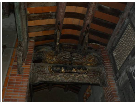
照片 2-6 木質構架的劣化檢測
