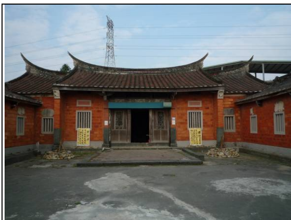
照片2-5 建築整體安全評估
