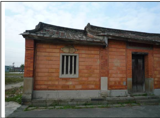
照片2-3 檢查屋面銜接處是否有漏水
