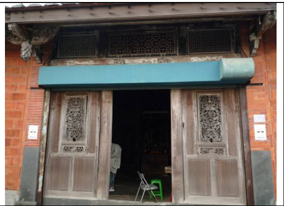
照片 2-4 檢查門窗是否有損壞情形
