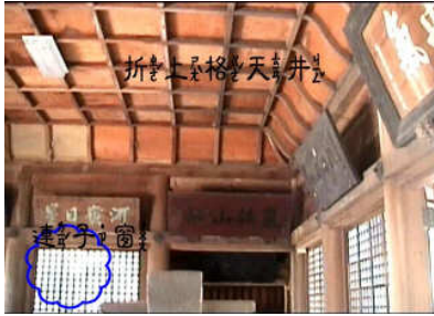
折上格天井：格子狀的天花板。 連子窗：直木條縱向排列有如柵欄的窗子。 十分
